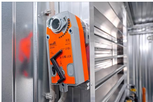
Внутри - автоматические клапаны притока-оттока воздуха с электроприводом Belimo 24/220 В
