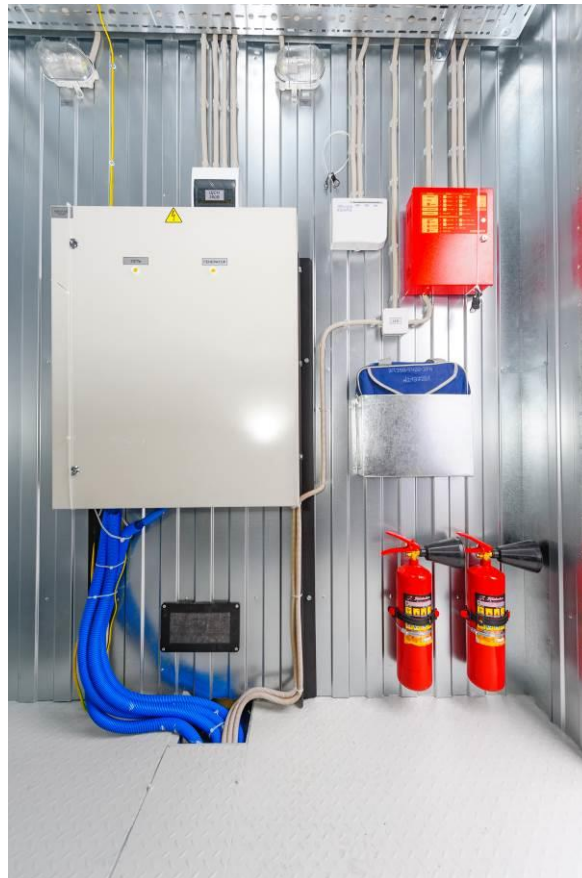
опция: Шкаф автоматического ввода резерва (АВР)
