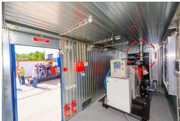
Тепло- и виброизолированная система газовыхлопа
