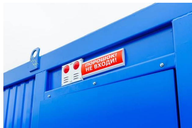
Внешнее световое табло «Порошок! Не входи», свето-звуковой пожарный оповещатель
