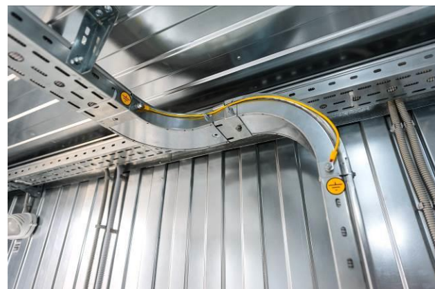
Верхняя разводка кабелей в гофрированных трубах - в подвесных металлических коробах (подвесные системы DKC, Италия)
