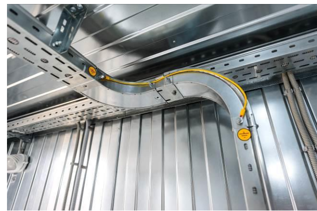
Верхняя разводка кабелей в гофрированных трубах - в подвесных металлических коробах (подвесные системы ДКС, Италия)
