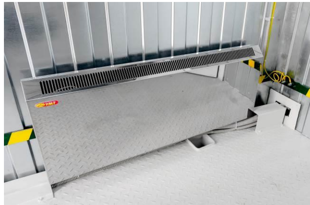
Электродный конвектор 220 В с автоматическим регулятором
