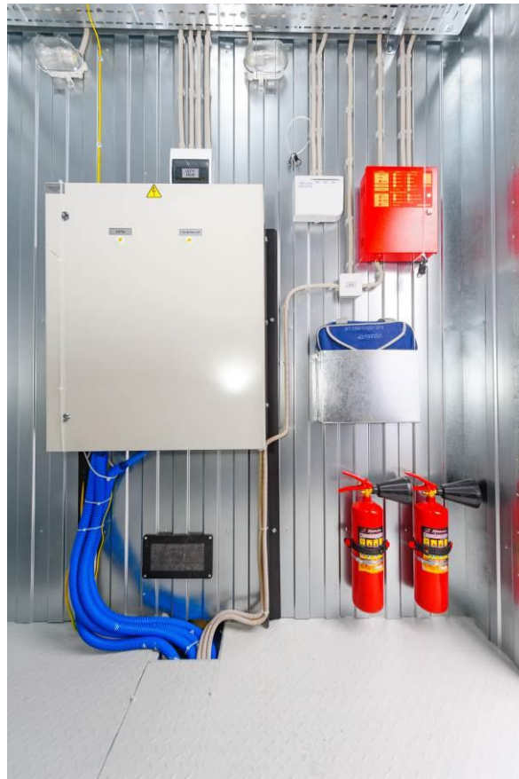
опция: Шкаф автоматического ввода резерва (АВР)
